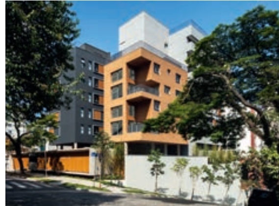
ARUÁ • FGMF RUA CAJAÍBA, 335 - PERDIZES
